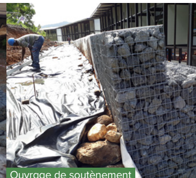
Ouvrage de soutènement
