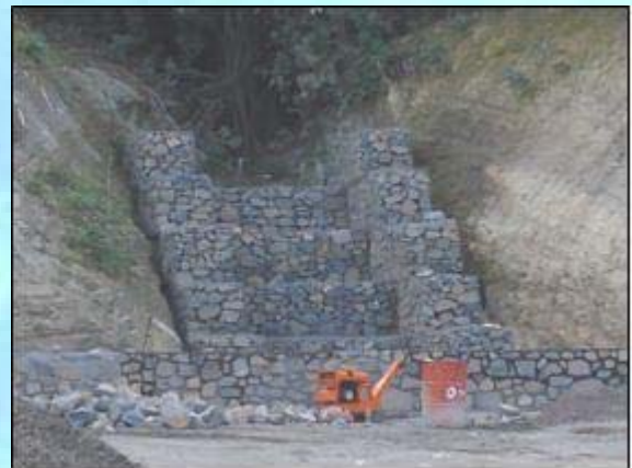
Réalisation d'un ouvrage de chute sur une ravine pour le lycée de Pamandzi (groupement Moe : JVO3 / SEIB / COTEL / MBE – conception : MBE)
